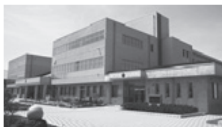
ブロック塀調査 全小中学校問題なし
