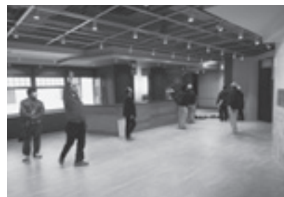
儀象堂の改修工事
